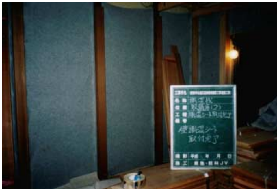
写真 4 . 壁調湿シート施工
