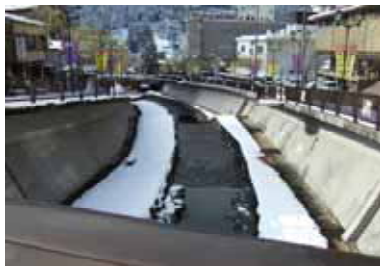
遊歩道はあまり利用されていない
