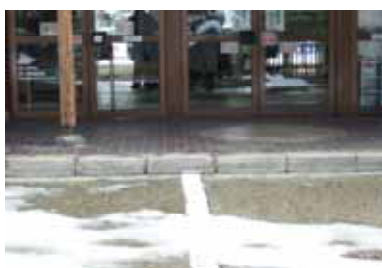
バリアフリーになっていない
