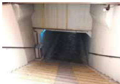
地下道が暗い
